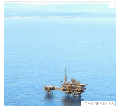
La plataforma marina del proyecto Castor, frente a las costas de Tarragona y Castellón.
