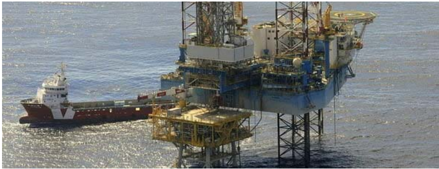
Fotografía de archivo de la plataforma del almacén subterráneo de gas natural del Proyecto Castor. Efe / Domenech Castelló
