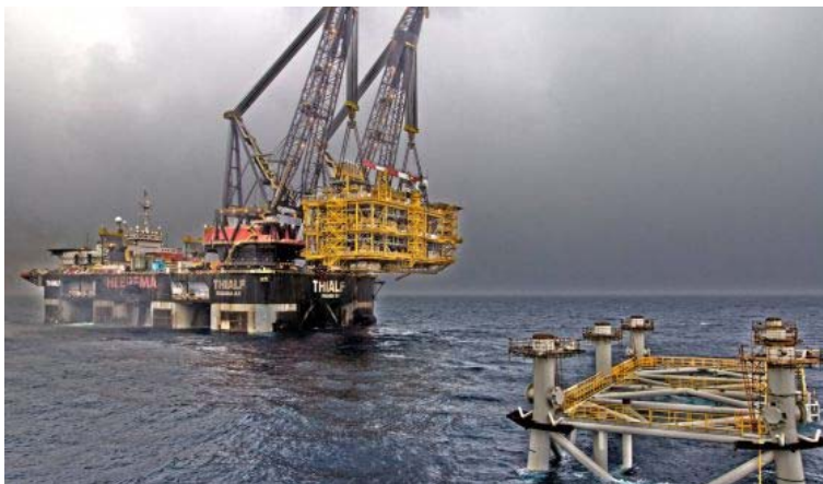
Instalación de la plataforma del proyecto Castor, en aguas de Castellón.
