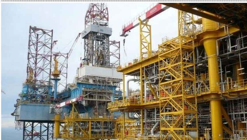
Las instalaciones de Castor frente al litoral castellonense
